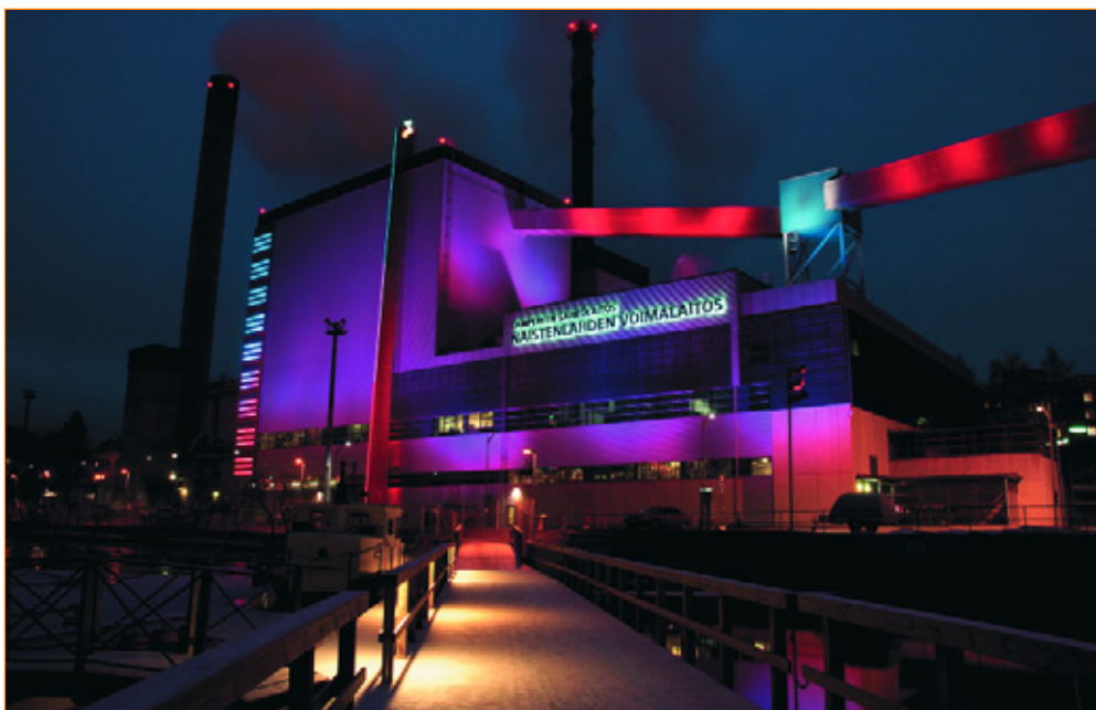
Система освещения электростанции в Тампере (Финляндия), разработанная компанией GE.
