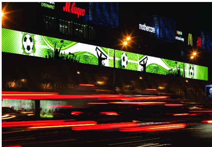
Москва, Кутузовский просп., 57. Площадь трех медиафасадов комплекса — 684 м 2 , 104,5 м 2 и 51 м 2 .
