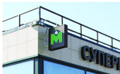
Завершают композицию два панель-кронштейна размером 0,8 x 0,8 м с логотипом «Мираторга» и внутренней светодиодной подсветкой.
