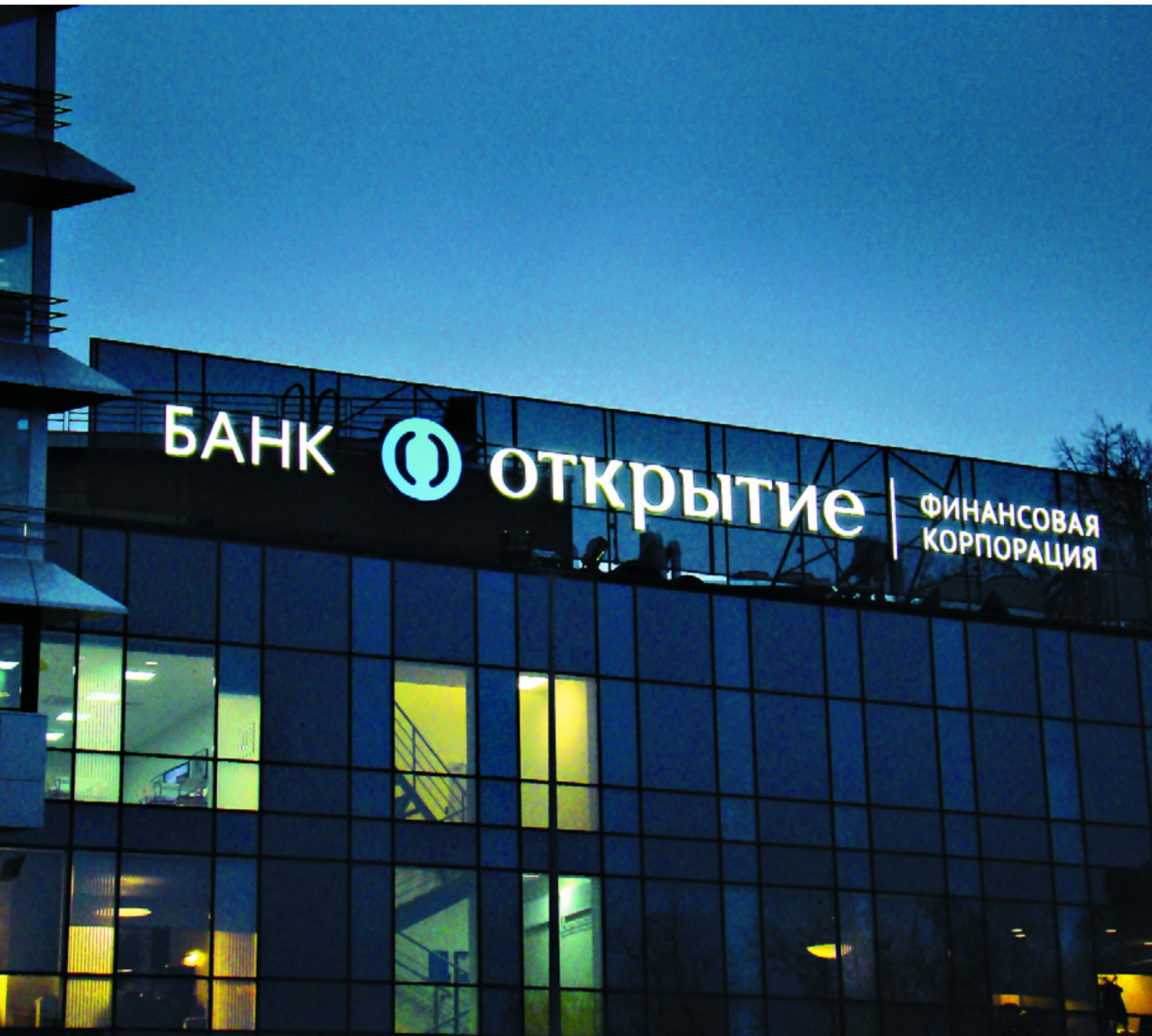
Крышная установка ФК «Открытие», Нижний Новгород. Изготовитель: «Латек».
