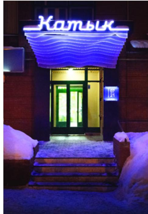
выгодно в контексте общего оформления. Входная группа имеет большой вынос — 3 x 2,8 метра. К фасаду она крепится при помощи тросов, боковые конструкции при входе — это не только архитектурное декоративное оформление, но и водосток, важное технологическое решение. Таким образом, входная группа бутика кулинарии «Катык» имеет современный, гармоничный внешний вид.
