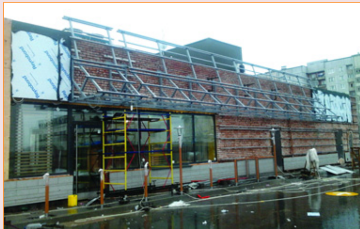
Начало установки обшивки
