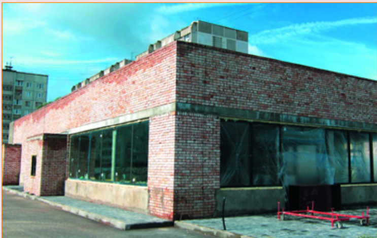
Исходный вид объекта
