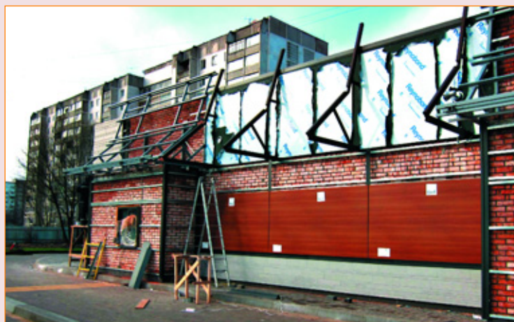
Установка обшивки
