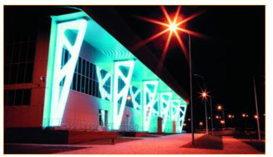
конструкцию. Оба экрана главного фасада (габаритные размеры каждого — 15 x 30 м, общая масса — 46 т) представляют собой несущие металлоконструкции, облицованные панелями из нержавеющей стали, толщиной 2 мм, с перфорацией в виде теннисных мячей, выполненной с применением технологии гидроабразивной резки. Поверх панелей смонтированы формованные элементы.
