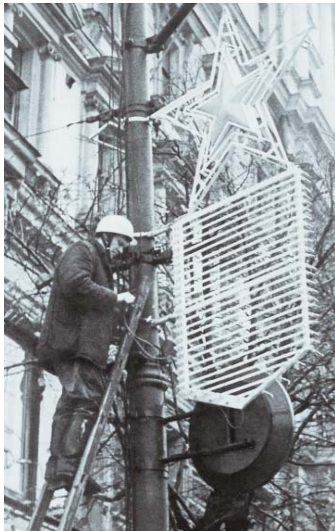
Рабочий Мосгороформления монтирует газосветный кронштейн на опоре освещения, Москва. 1974 г.
