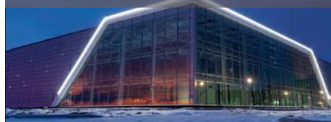
Контур стеклянного витража и «звездное небо» на фасаде создают светильники SMART Line и 5000 smart-модулей.
