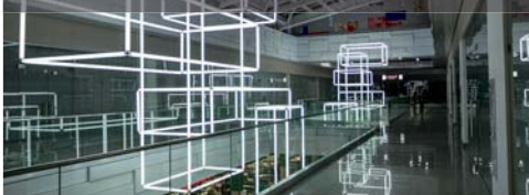
В ТРЦ – 8 массивов светильников из поликарбонатных труб со светодиодной лентой ML-R60-2835 внутри.
