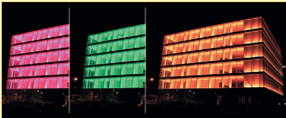
*Оформление системой программируемого света здания в Женеве. В каждое окно размещен блок ламп, контролируемый отдельно. Благодаря этому можно выстраивать световые сценарии, используя каждое окно, как отдельную цветовую ячейку.*
